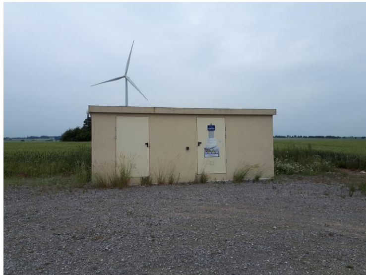
Figure 14 : poste de livraison du parc éolien de Remigny-Ly-Fontaine (source : ENERTRAG, 2018)
